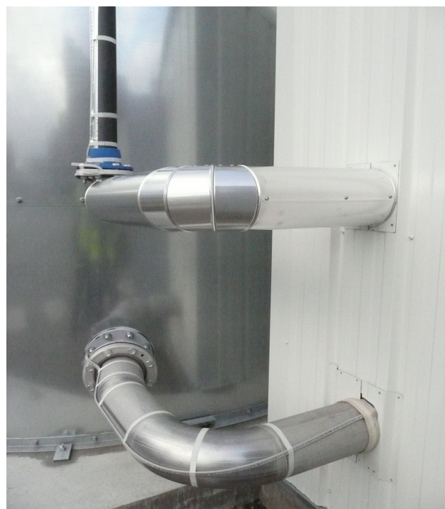
Collerettes d'arrêts sanpon™ permettant le passage et la protection du câble
