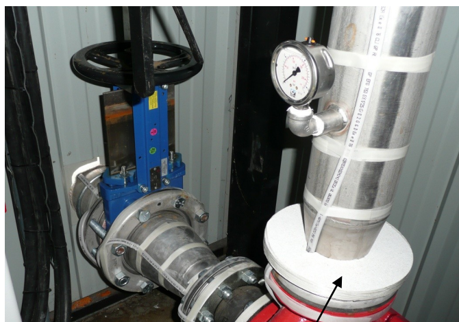
Collerettes d'arrêts sanpon™ permettant le passage et la protection du câble
